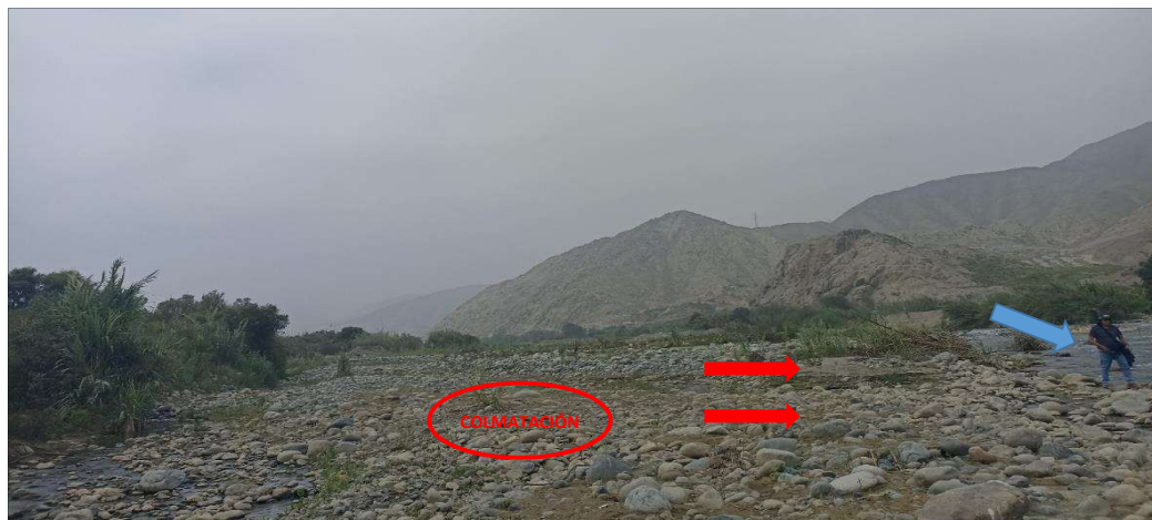
FIGURA N°03: TRAMOS EN LA MARGEN DERECHA DEL RIO CHANCAY - HUARAL EN EL SECTOR SAUME - LINDERO CON DEFENSA VIVA Y MATERIAL GRANULAR, OCASIONA QUE EL DESBORDAMIENTO DEL CAUCE DEL RIO SEA MAS INMINENTE EN EPOCAS DE AVENIDAS.
