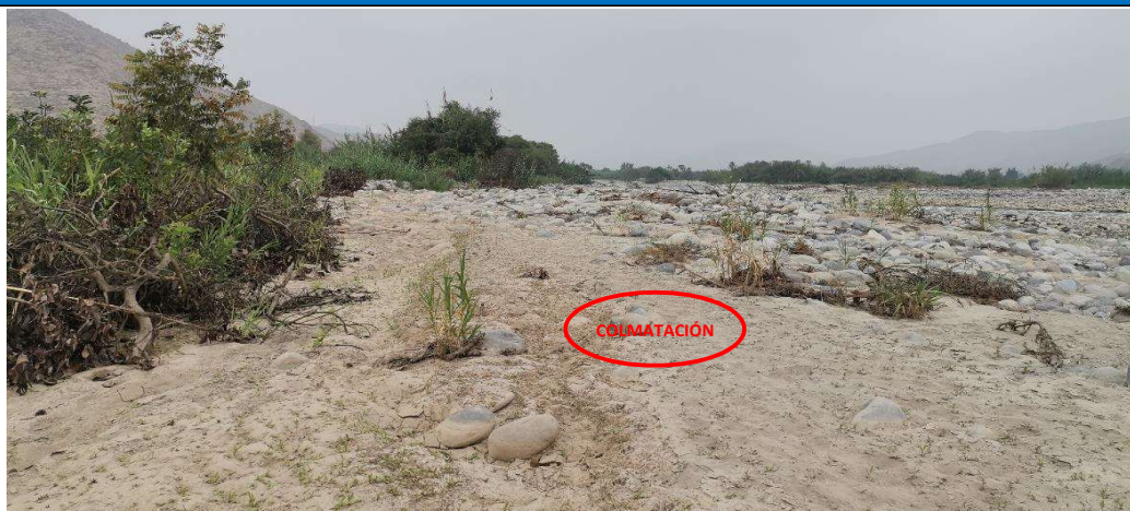
FIGURA N°01: PROGRESIVA KM 27+500 DEL RIO CHANCAY - HUARAL COLMATADO EN EL SECTOR BOCATOMA PALPA-HORNILLOS, CON LA PRESENCIA DE: VEGETACIÓN, ARENA FINA Y MATERIAL GRANULAR; LAS CUALES DEBEN SER DESPLAZADOS HACIA AMBOS MARGENES PARA MANTENER SU SECCIÓN HIDRÁULICA .
